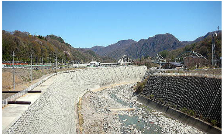
Le rive cementificate di un fiume .
