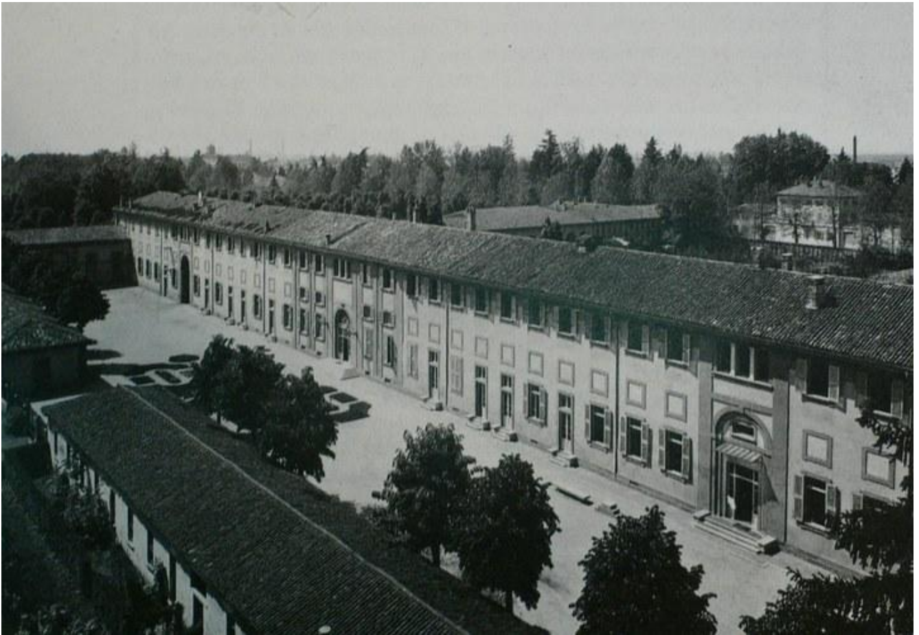
Veduta aerea dell'ala sud della Villa Reale di Monza, dove era ospitata l'Università delle Arti Decorative.
