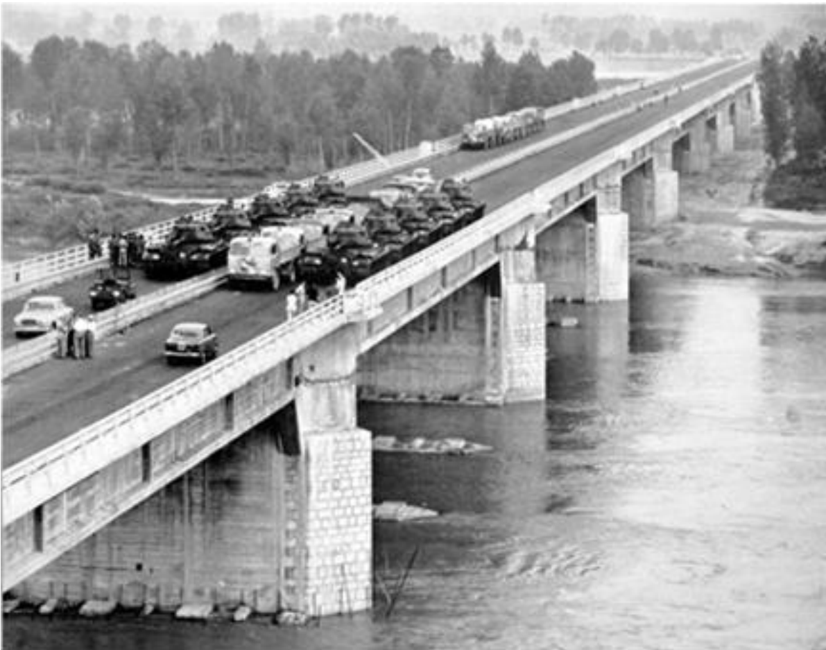
Ponte sul Po presso Piacenza. Collaudo 4-5 giugno 1959.
