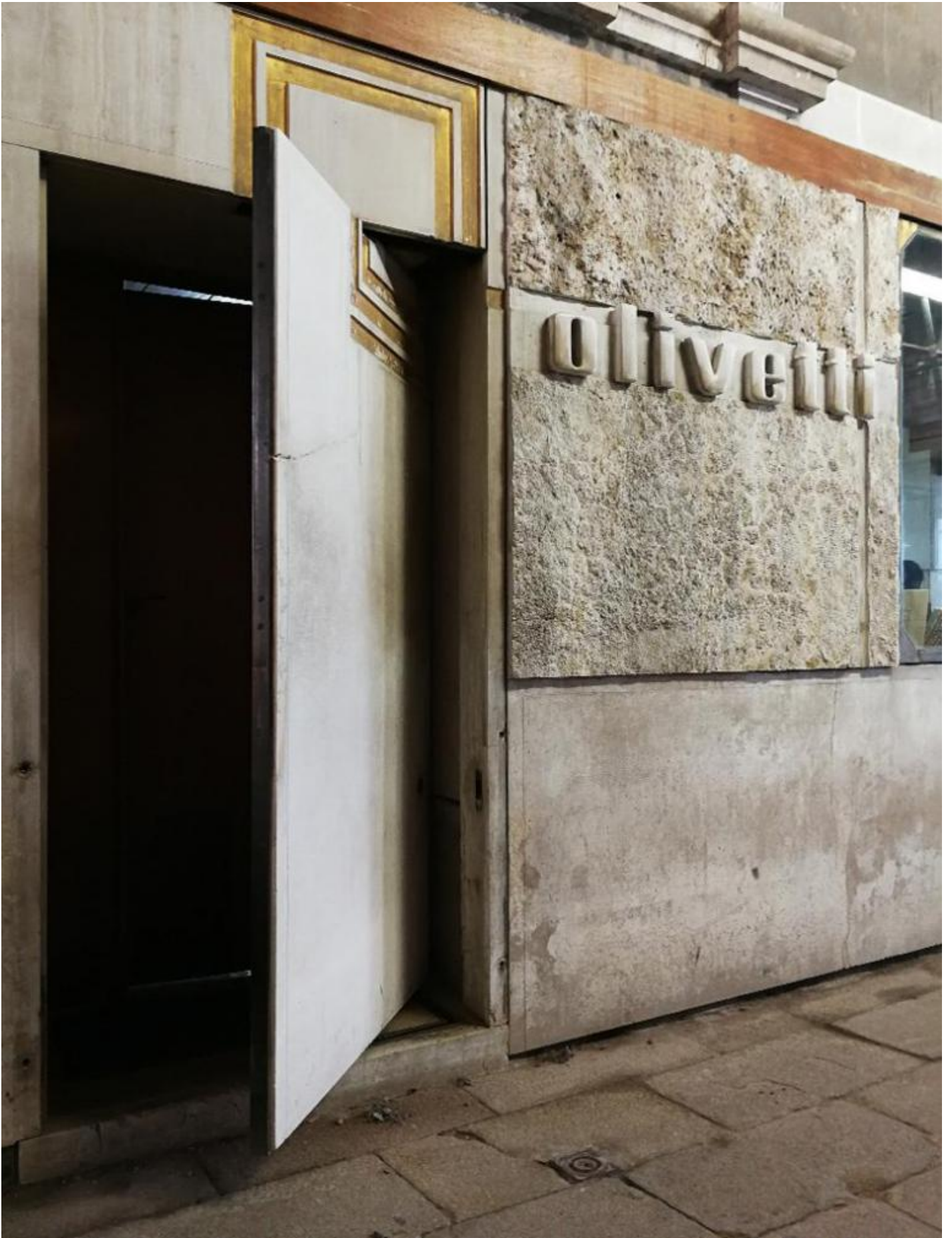
Carlo Scarpa, negozio Olivetti, 1957-58. Venezia, piazza San Marco. Ingresso laterale.
