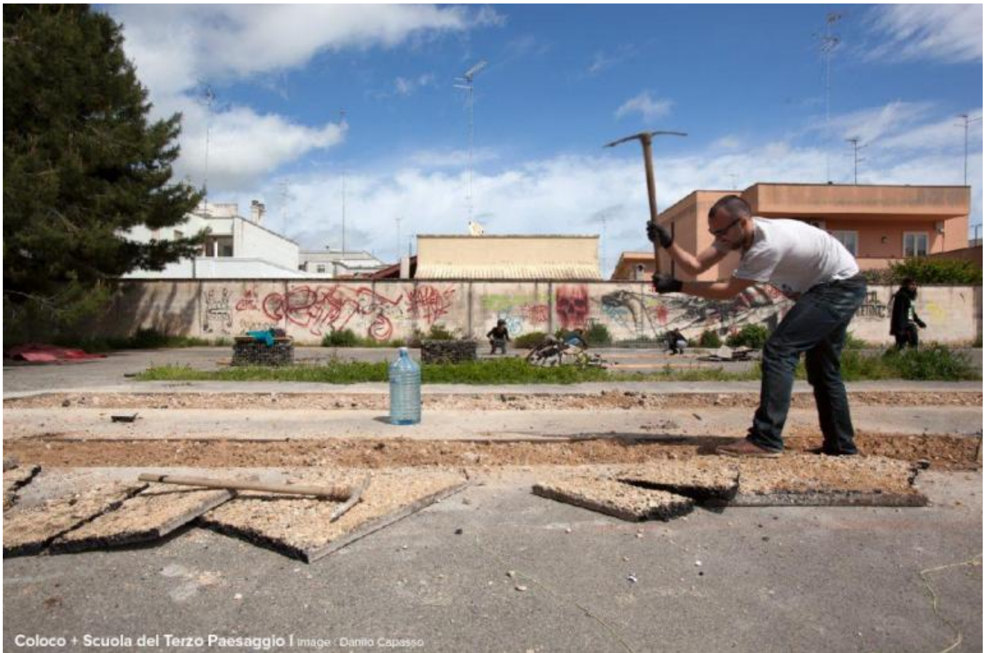
Atelier Coloco, Scuola del Terzo Paesaggio. Asfalto non amour. Lecce, Italia, 2016. Foto Danilo Capasso.
