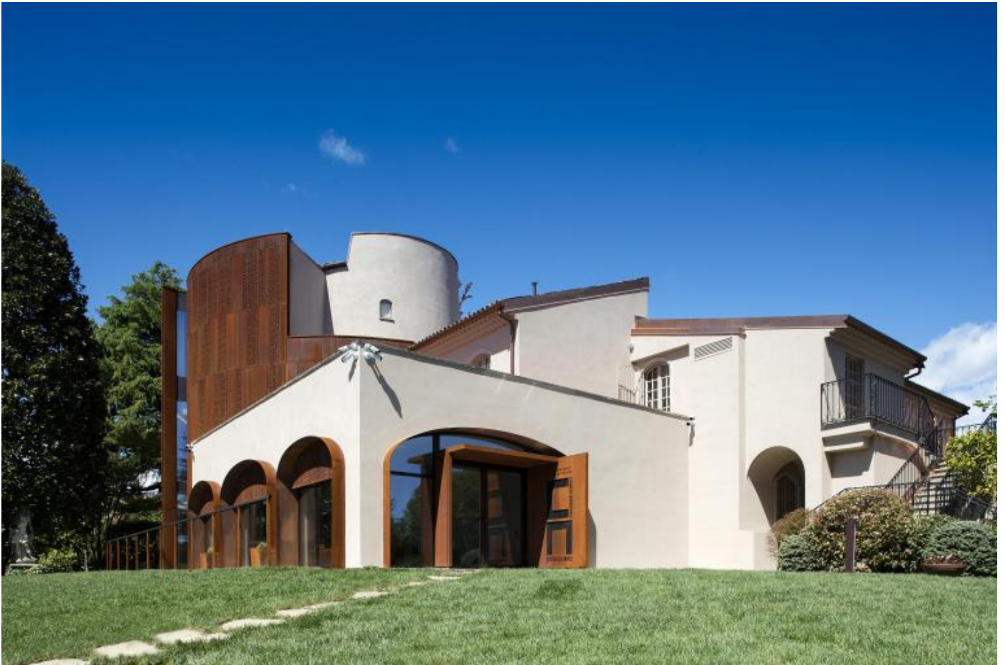
Villa Cerruti esterni.
