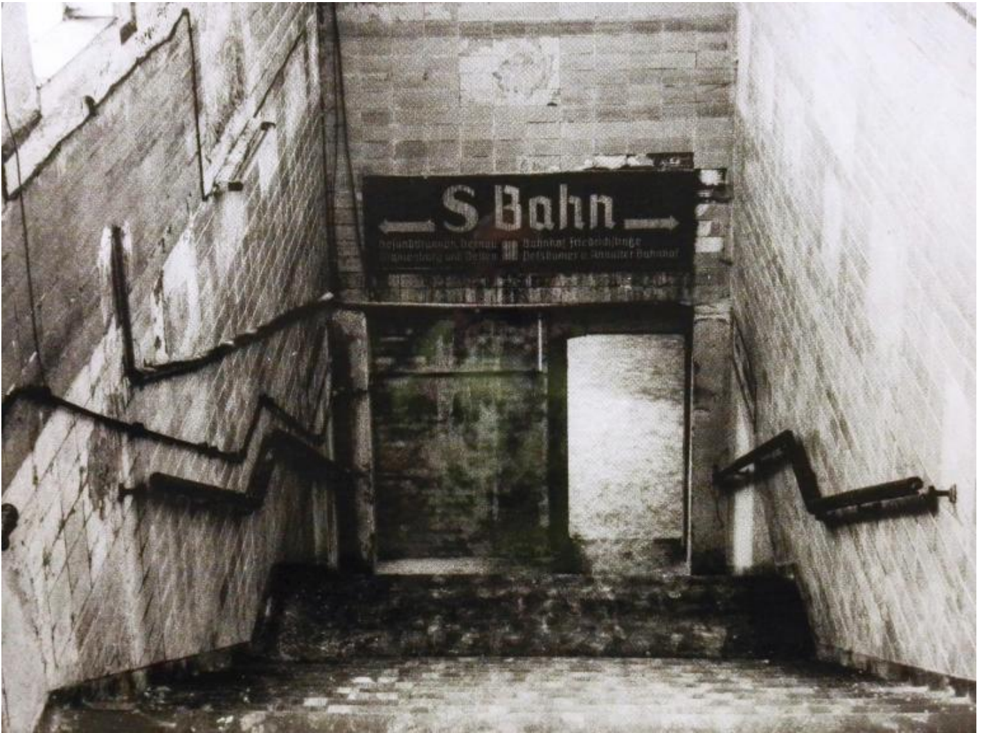
L'accesso murato alla stazione S-Bahn di Nordbahnhof.
