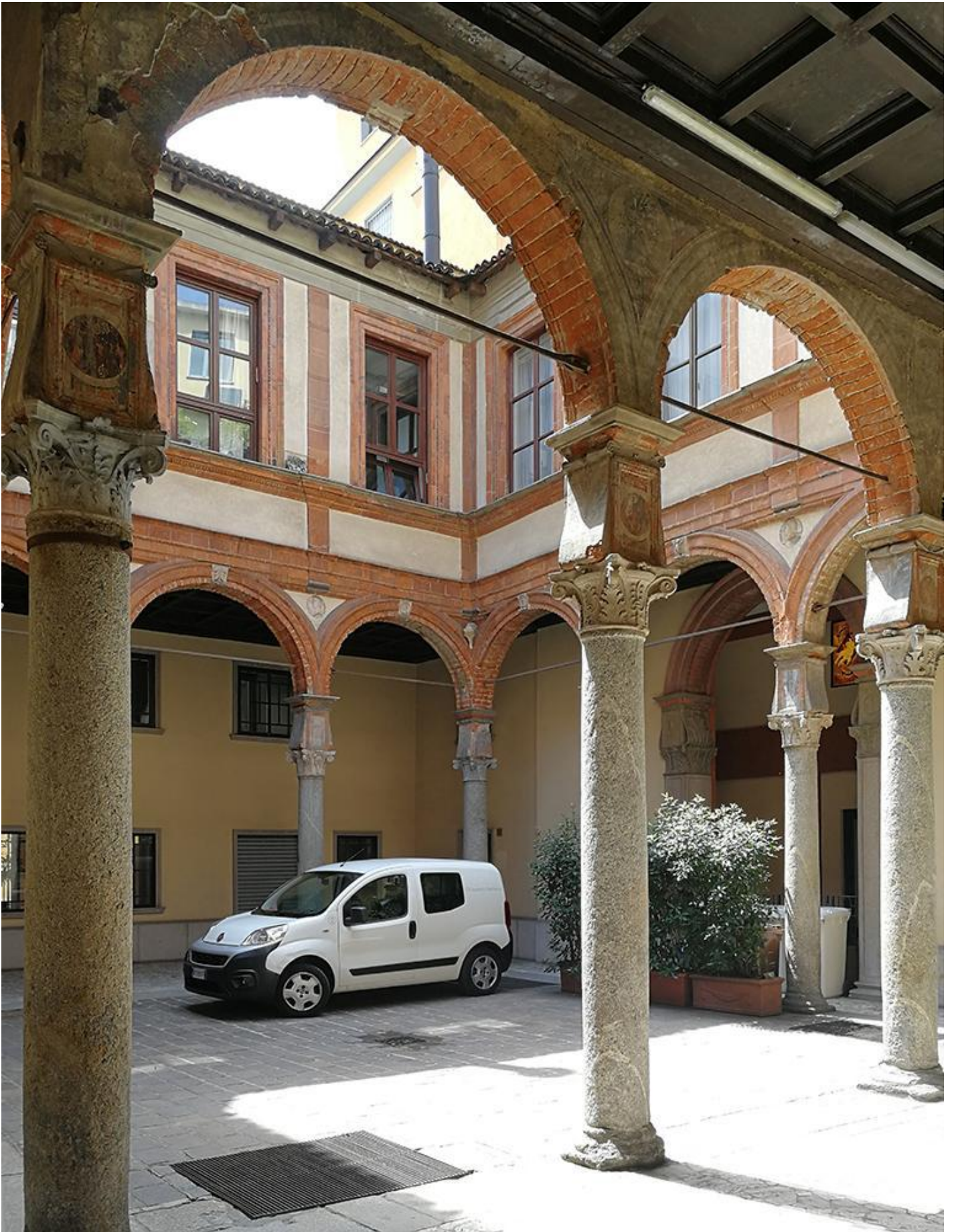
Palazzo Botta, veduta del cortile.
