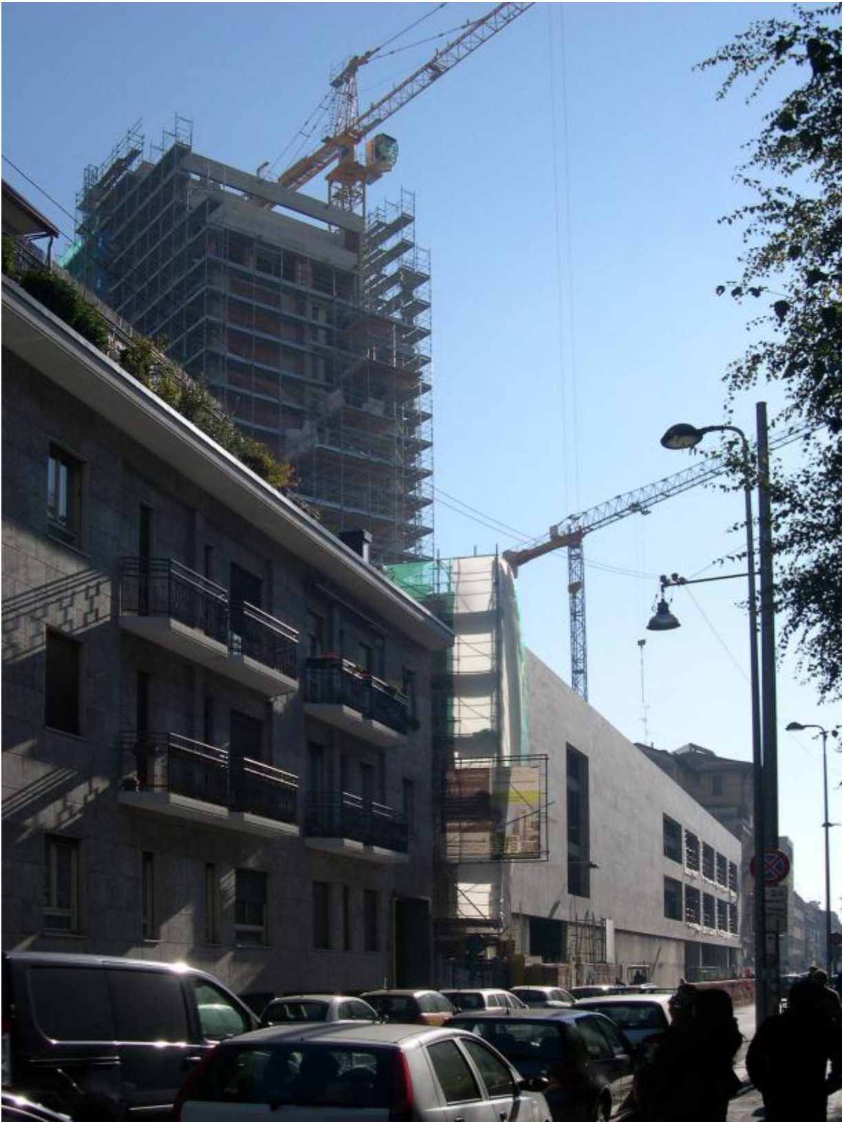
L'intervento in fase di realizzazione, Milano 2010
