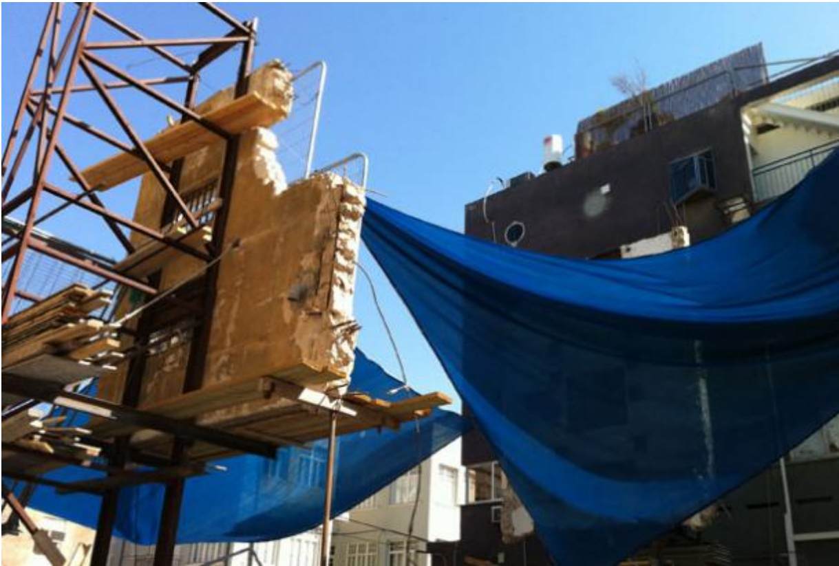
Un cantiere di muri sospesi a Jaffa
