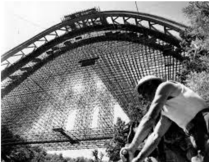
Domus: viadotto dell'Autostrada del Sole in costruzione
