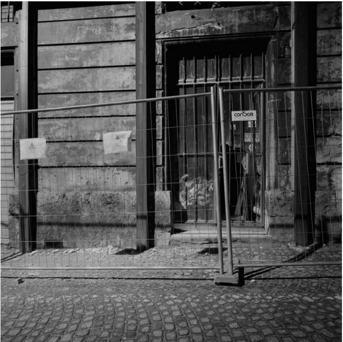
L'Aquila centro storico, novembre 2010
