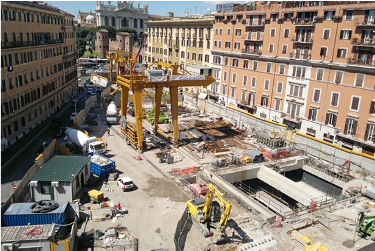
Roma, cantiere della Linea C
