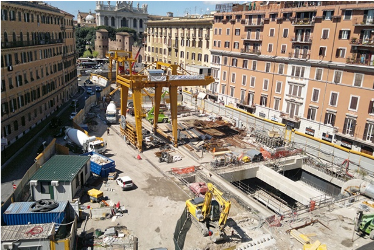
Roma, cantiere della Linea C
