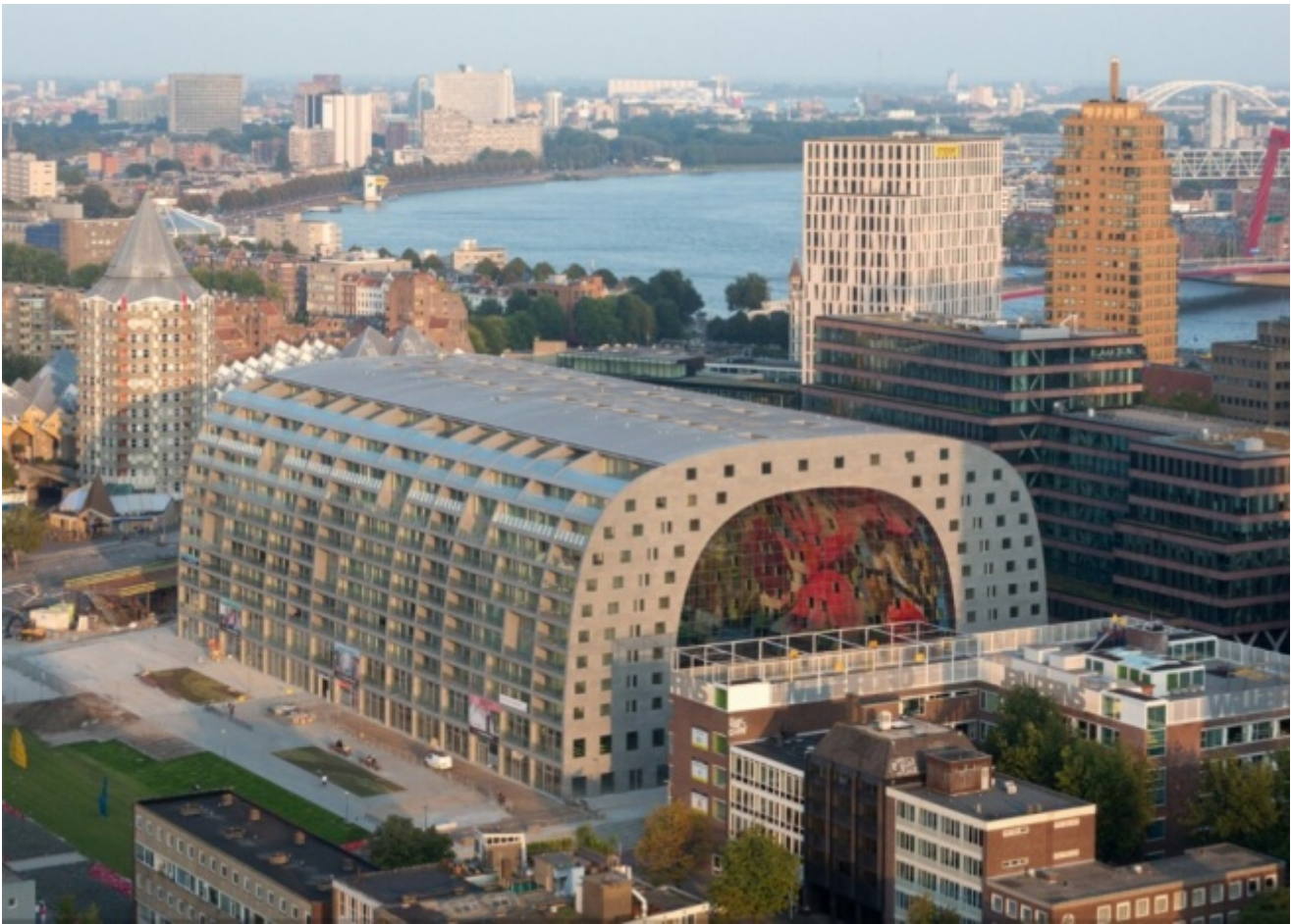
Market Hall di Rotterdam progetto degli MVRDV, 2004-2014
