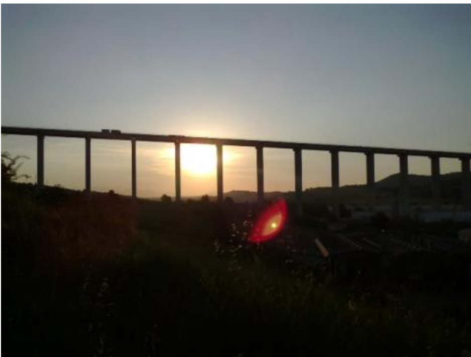
Dormire vicino a un ponte
